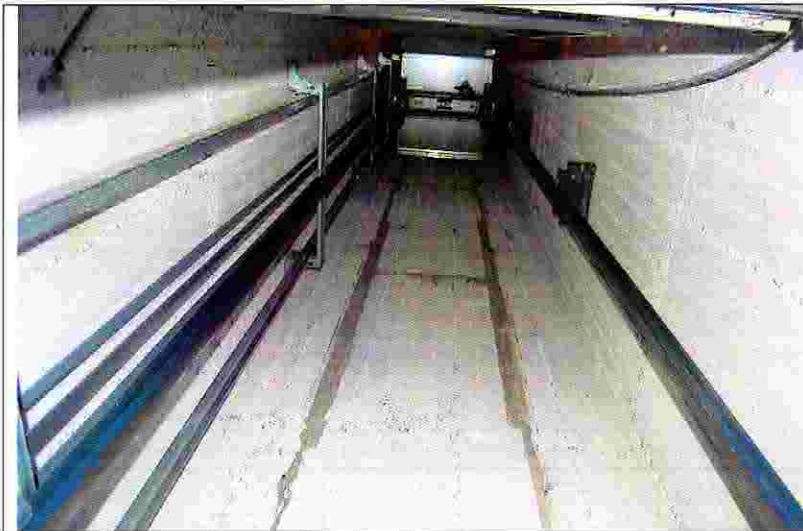
Phase n.1 – Building n. 1 – Guide rails and cabin installed
