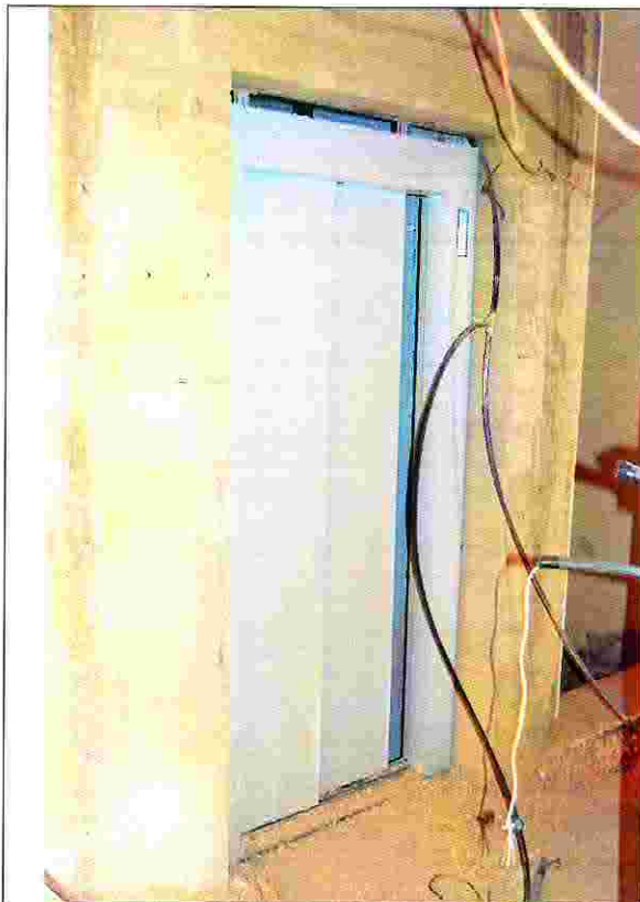
Phase n.1 – Building n. 1 – Floor level - Door frames installed
